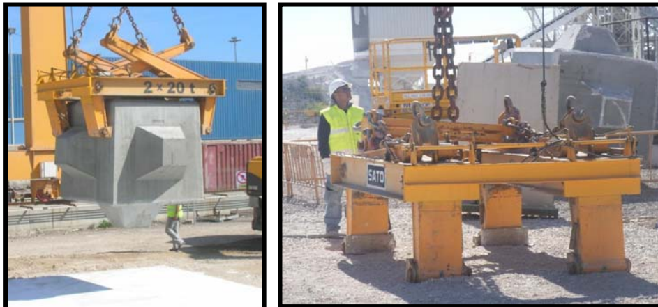
Figura 8. Pinzas doble adaptadas para la manipulación de cubípodos.
