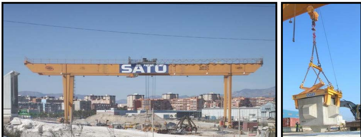
Figura 11. Puente grúa de SATO en el Parque de Bloques del Puerto de Alicante.
