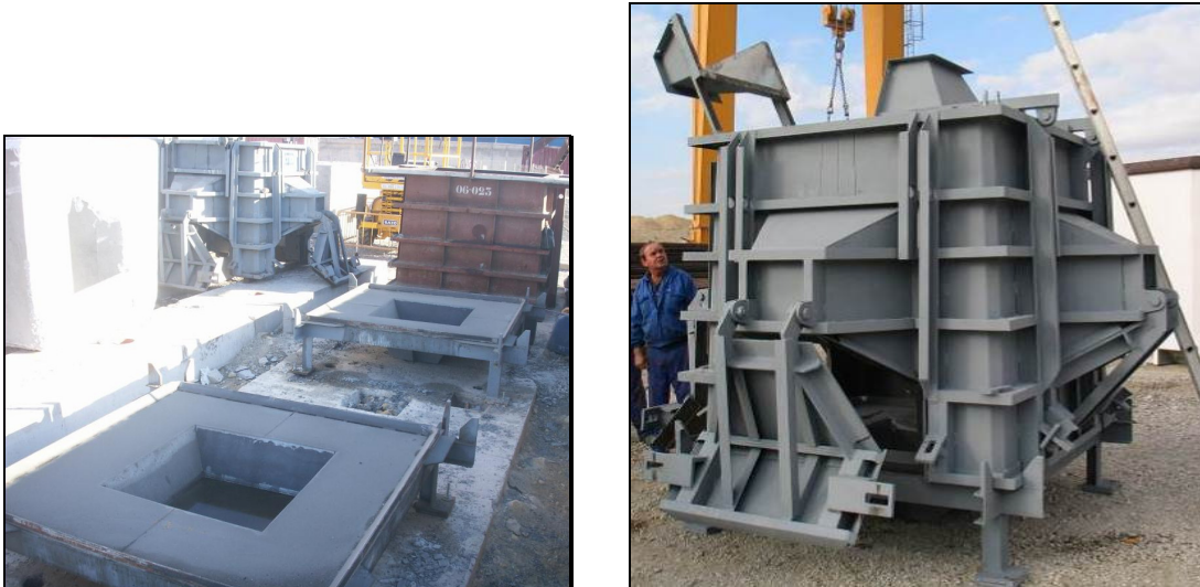
Figura 6. Bases del encofrado y encofrado superior articulado sobre base del Cubípedo.
