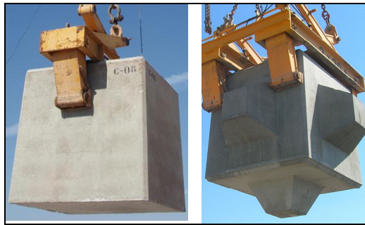
Figura 4. Manipulación con pinzas de presión de cubos y cubípodos.
