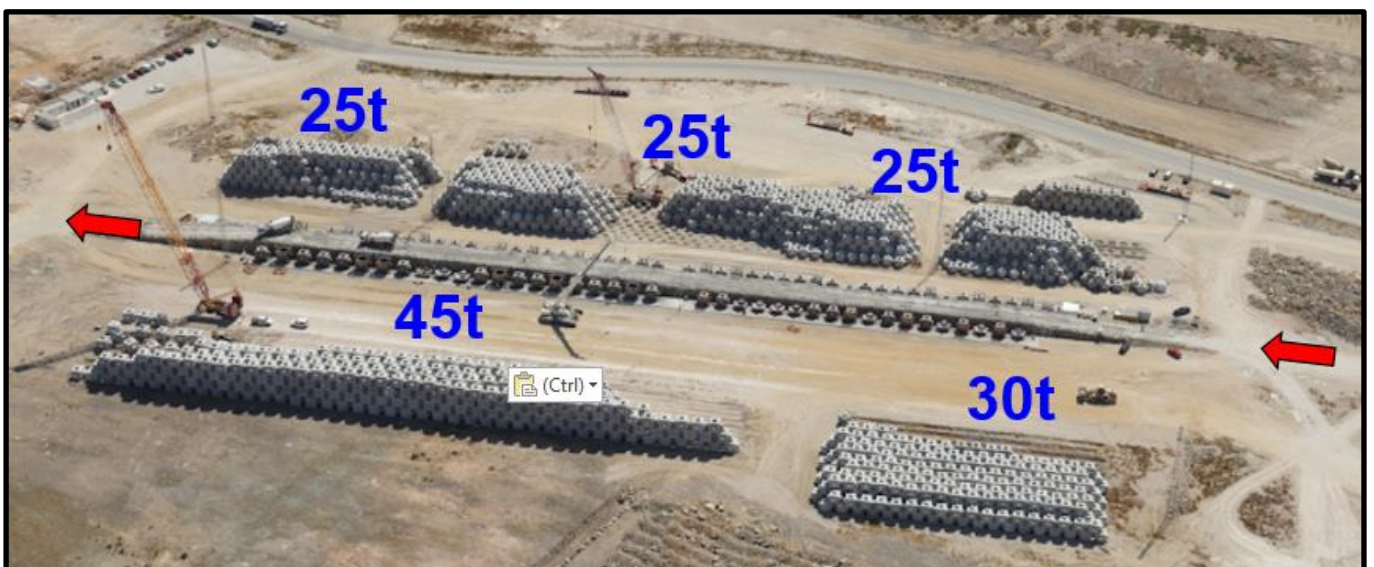
Figura 6. Vista aérea del parque de Cubípodos del Dique Oeste (7 de julio de 2015).
