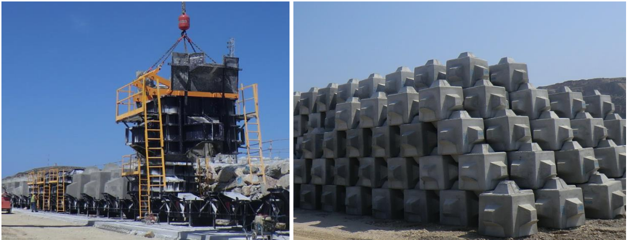
Figura 12. Línea de producción de Cubípodos de 45 t y acopio a 5 alturas (29/05/2015).
