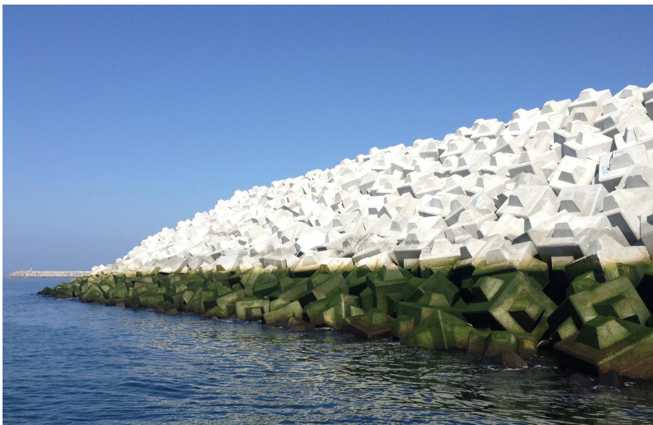
Figura 14. Aspecto exterior del Dique oeste en construcción (1/10/2015).
