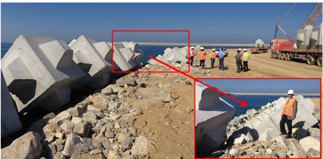
Figura 13. Vista de la transición monocapa-bicapa de Cubípodos de 25 t (1/10/2015).
