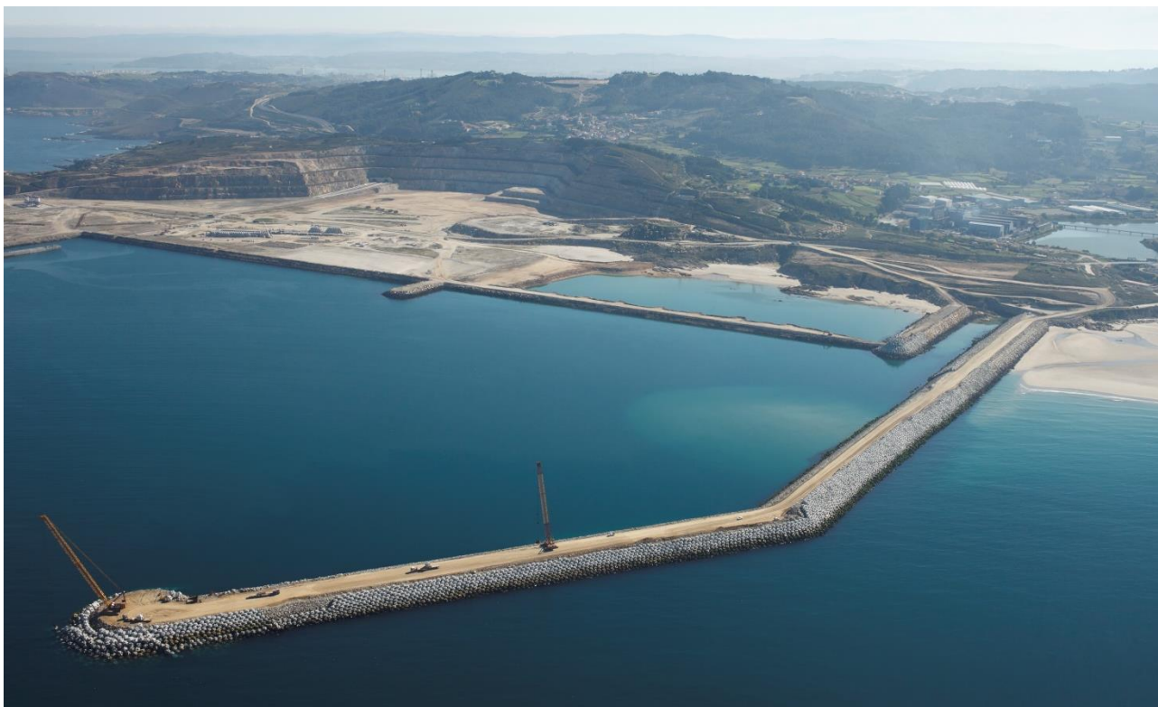
Figura 15. Vista aérea de del Dique Oeste en construcción (29/9/2015).
