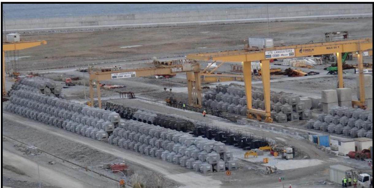
Figura 12. Fabricación y acopio de Cubípodos en Punta Langosteira.
