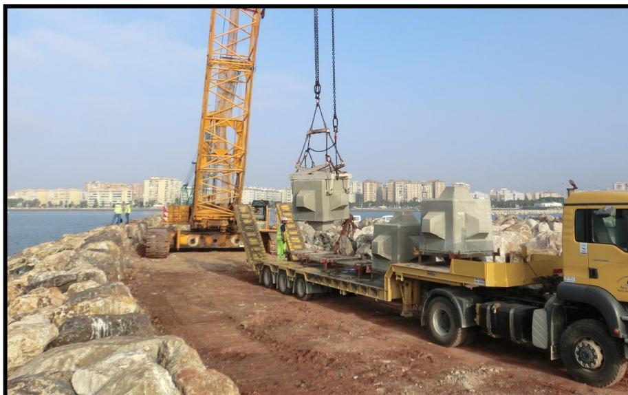
Figura 11. Inicio del ciclo de colocación de un Cubípedo de 6 t en dique de San Andrés.
