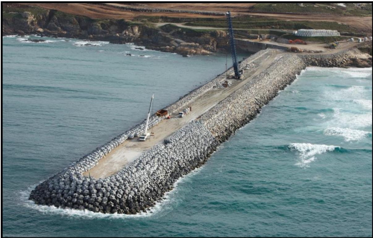
Figura 2. Contradique de Cubípodos monocapa en Punta Langosteira.
