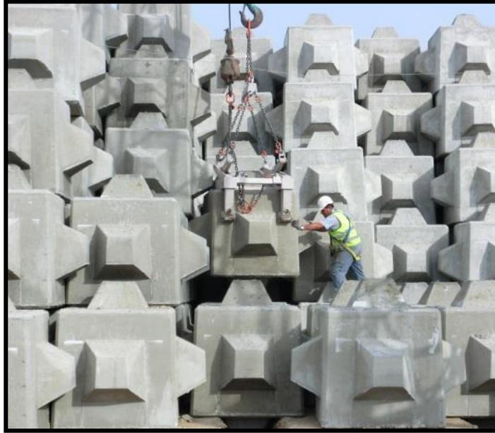
Figura 8. Acopio de Cubípodos de 6t en parque.
