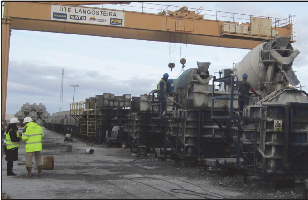
**Figura 1.6 Suministro de hormigón para fabricación de Cubípodos de 25t.**
