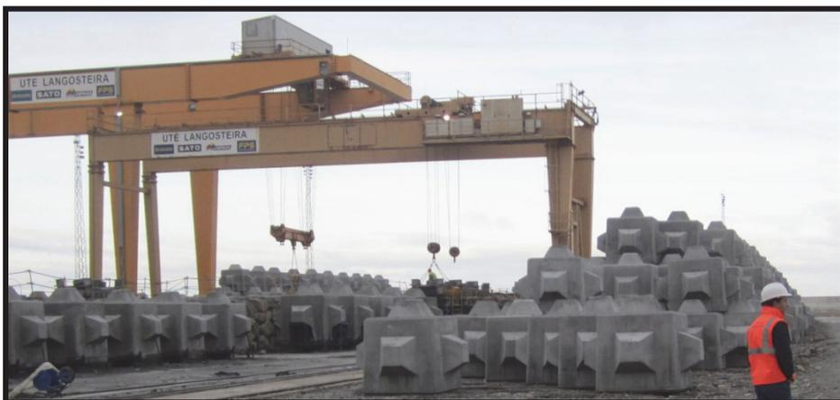
**Figura 5.4 Parque de Cubípodos atendido con puentes grúa (Punta Langosteira).**
