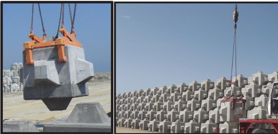
**Figura 5.2 Pinzas de presión dobles para la manipulación de Cubípodos.**
