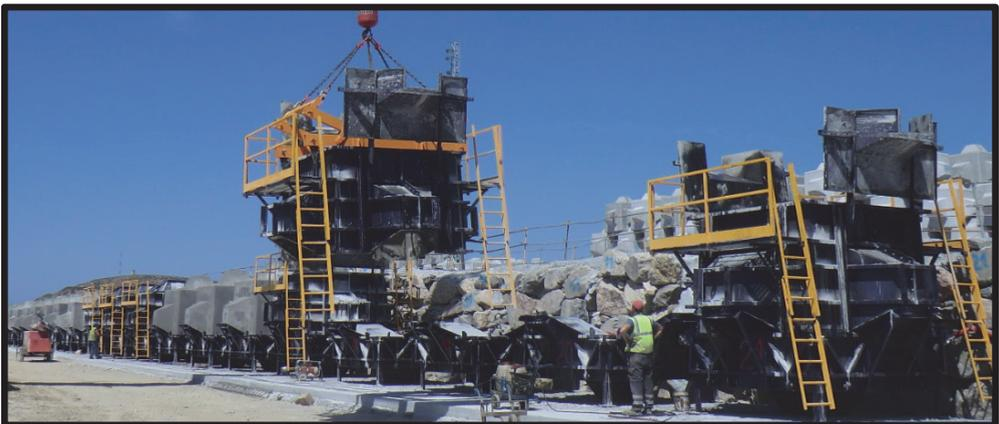
Figura 5.1 Encofrados verticales del Cubípedo® de  $19 \text{ m}^3$  con sus bases.
