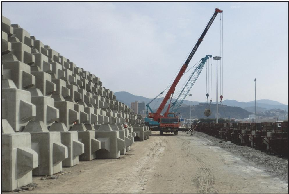
**Figura 1.8 Fabricación y acopio de Cubípodos en el parque de bloques del Puerto de Málaga.**
