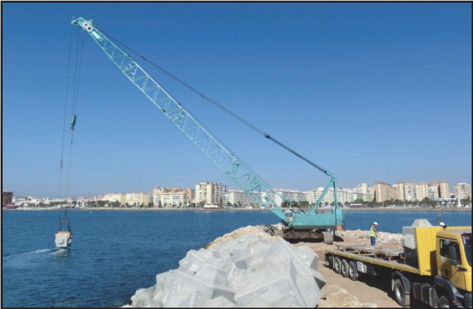
**Figura 6.2 Colocación de Cubípodos. Dique de San Andrés (Puerto de Málaga).**
