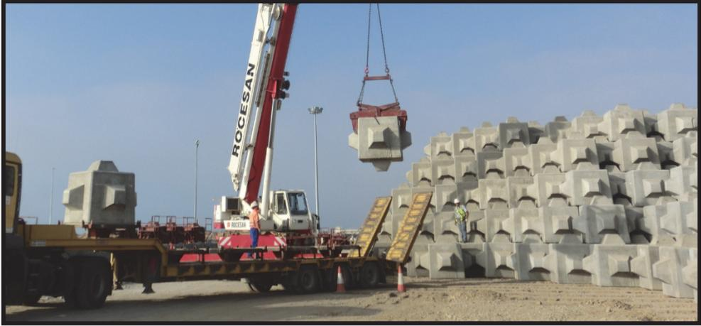
**Figura 5.10 Carga de Cubípodos sobre góndola para su transporte a la zona de colocación.**
