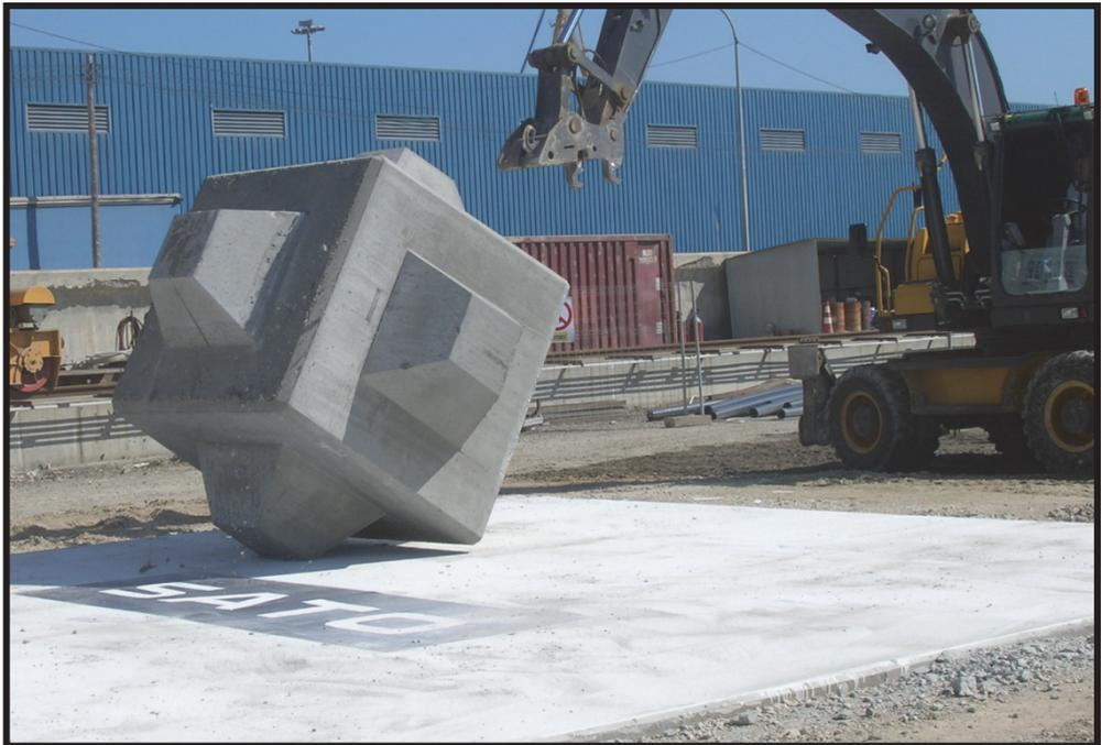
**Figura 4.1** Plataforma de volteo de hormigón armado (10.0x7.5x0.9 m).
