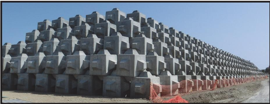
**Figura 5.3 Acopio a cinco alturas en el parque de Cubípodos del Puerto de Málaga.**
