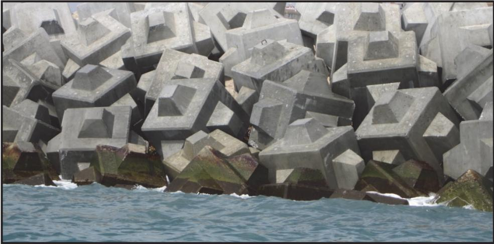
**Figura 1.1** Cubípodos de 6t en el manto bicapa del Dique de San Andrés (Puerto de Málaga).
