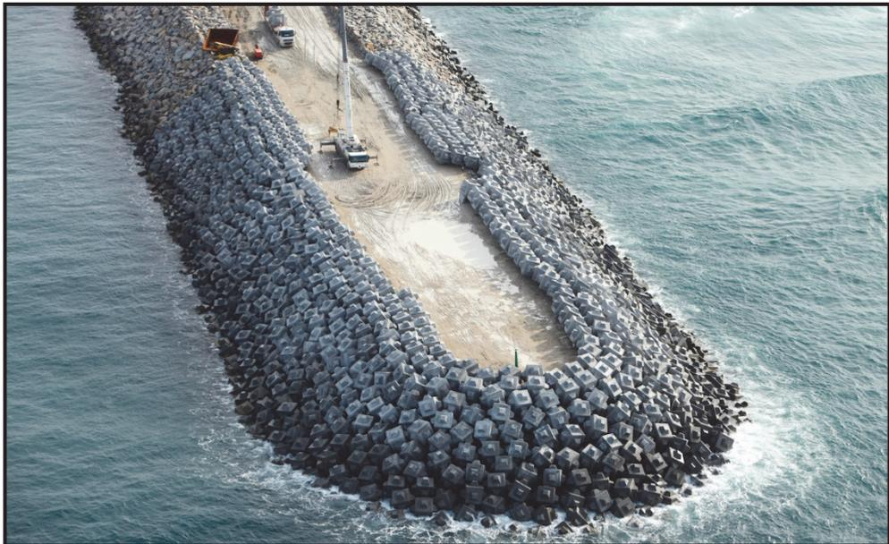
**Figura 6.1** Cubípodos en una sola capa colocados en el Dique Sur de Punta Langosteira.
