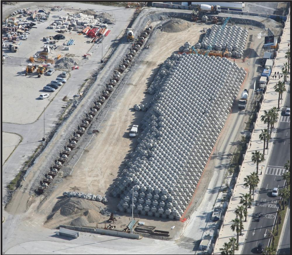
**Figura 5.7 Parque extensivo de Cubípodos con grúas móviles en el Puerto de Málaga.**
